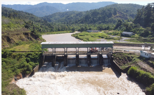
PLTA Air Putih 21 MW Bengkulu
