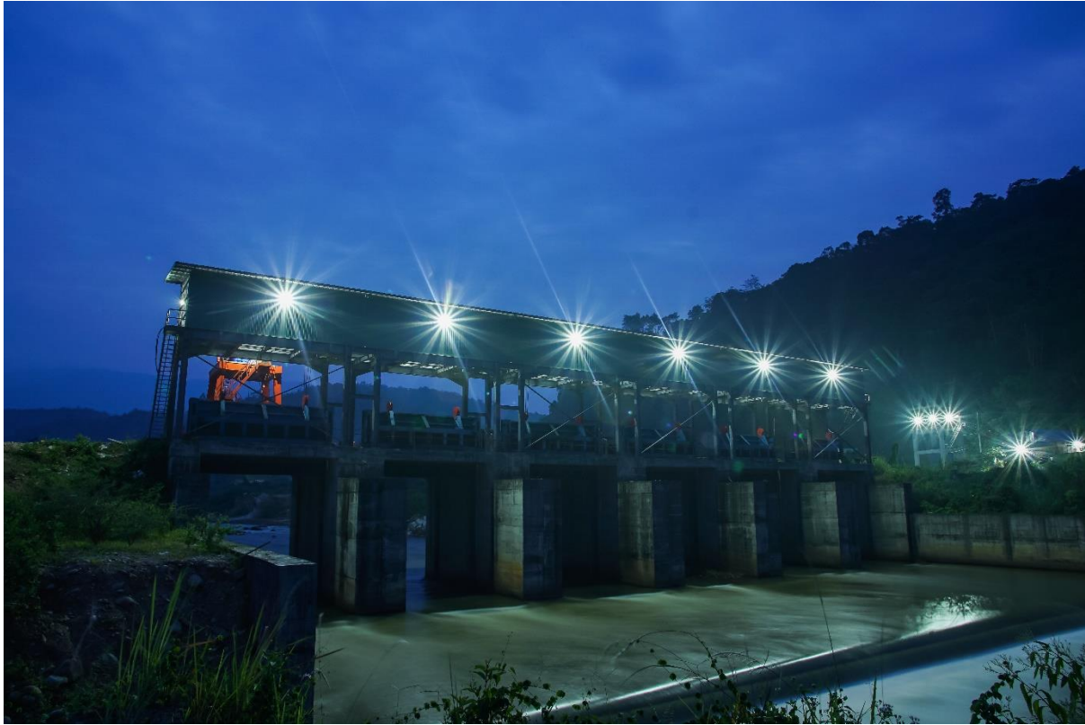
PLTA Air Putih (PT BTL) – PT Kencana Energi Lestari Tbk
